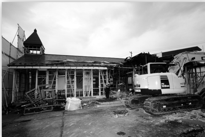
取り壊し中の旧会堂
