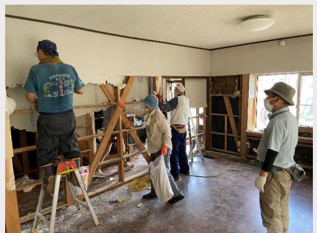
牧師館での壁はがし作業
