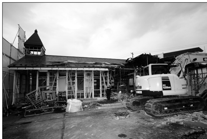
取り壊し中の旧会堂
